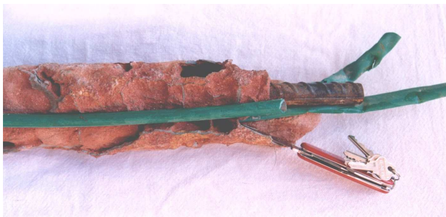
Foto 3 – Amostra escavada de Chumbador injetado com calda de cimento.
