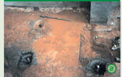
Micro estacas para reforço da parede do poço
