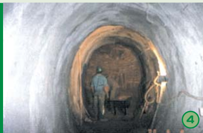
Avanço do túnel pelo método austríaco, utilizando concreto projetado com fibras de aço
