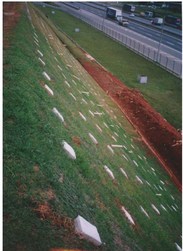
Figura 8: Vista da Obra Concluída
