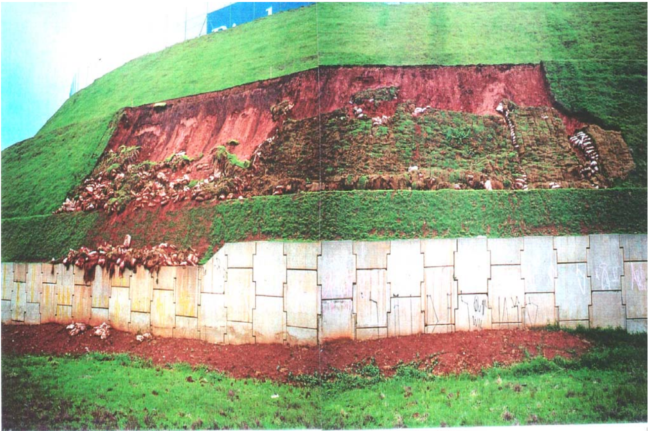
Figura 2: Vista de um dos escorregamentos após a recomposição com sacos de solo-cimento
