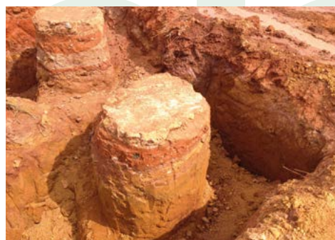
Figura 3 - Colunas escavadas - Aferição de diâmetro.
