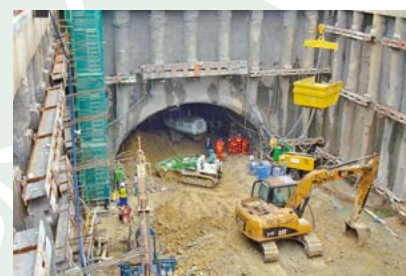
Figura 8 - Túnel metroviário, com seção de 66,0m².
