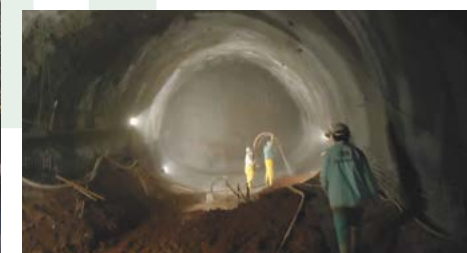
Figura 12 - Túnel de interligação entre edifícios.
