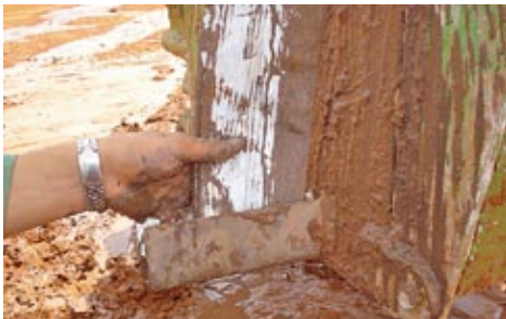
Figura 5 - Detalhe de ponteira metálica presa ao geodreno
