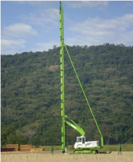
Figura 4 - Equipamento em serviço de cravação de geodrenos
