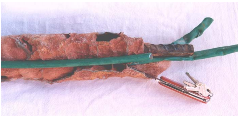
Foto 3 - Muestra excavada de Perno de Anclaje inyectado con lechada de cemento.
