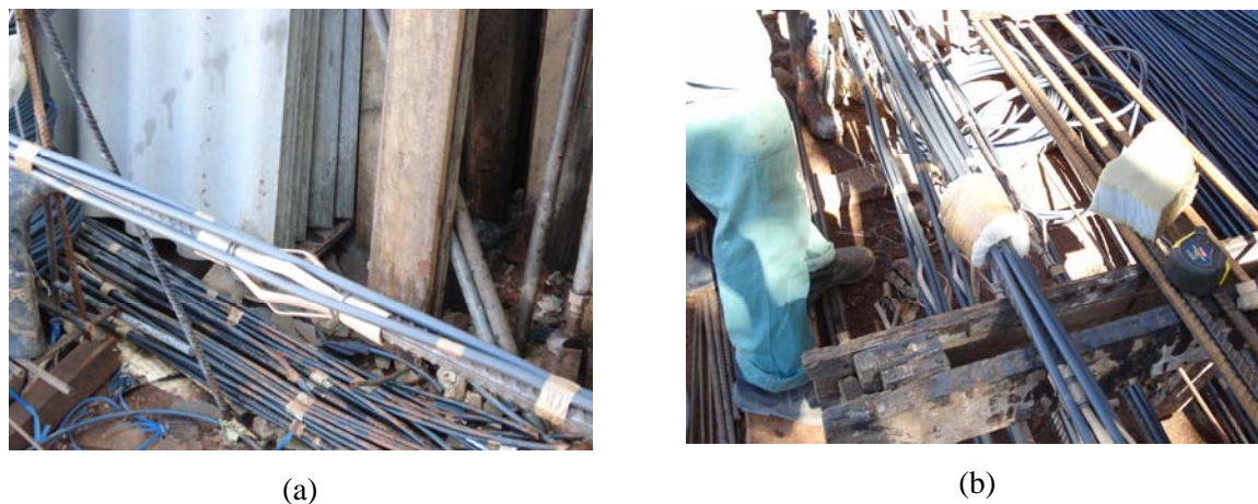
Figura 4. Detalhe da preparação das barras de aço. (a) Posicionamento dos tubos de injeção e centralizadores e (b) espuma enrolada no início do trecho livre.
