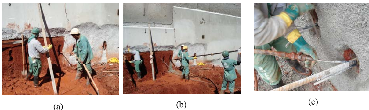
Figura 6. (a) Detalhe da execução da bainha, (b) inserção do chumbador no maciço de solo após a execução da bainha e (c) fixação do equipamento de injeção.
