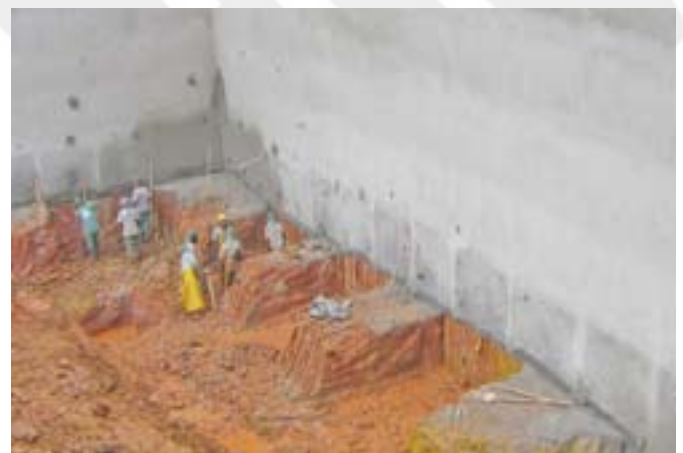
Figura 5 - Excavación manual con bermas entre las partes excavadas.
