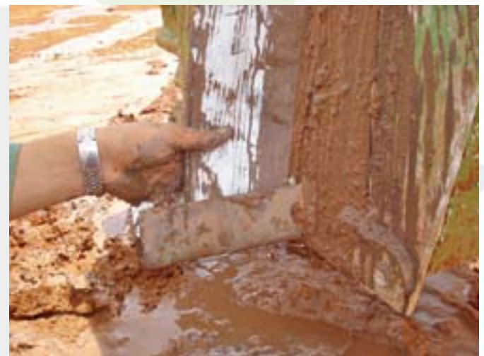
Figura 5 - Detalhe de ponteira metálica presa ao geodreno
