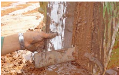
Figura 5 - Detalhe de ponteira metálica presa ao geodreno
