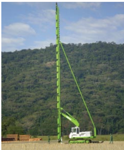
Figura 4 - Equipamento em serviço de cravação de geodrenos
