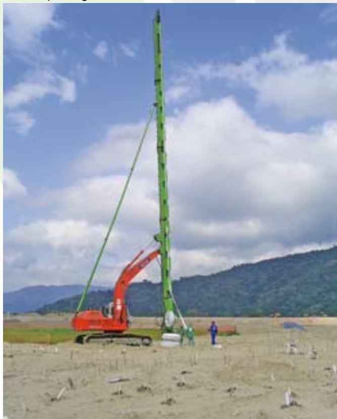
Figura 4 - Equipamento em serviço de cravação de geodrenos
