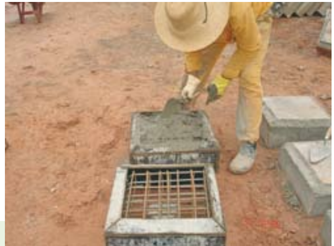
Figura 10 - Execução de capitel para alluvial anker
