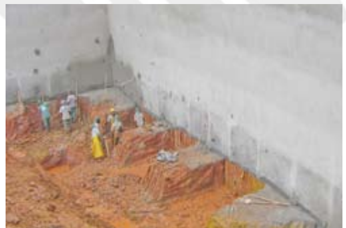
Figura 5 - Escavação manual com bermas entre as partes escavadas
