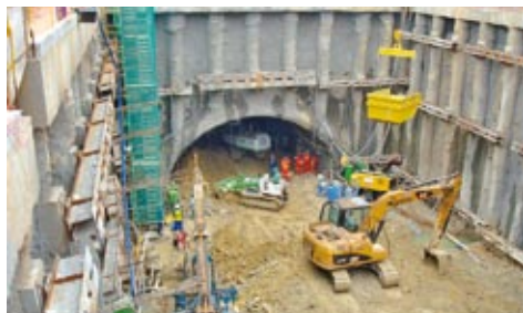
Figura 11 - Túnel metroviário, com seção de 66,0m 2
