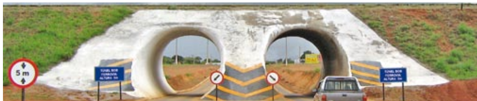
Figura 12 - Túnel rodoviário sob ferrovia, com seção de 34,0m 2 cada
