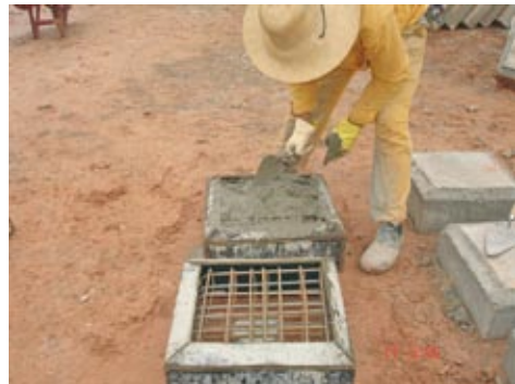
Figura 10 - Execução de capitel para alluvial anchor, no local da obra
