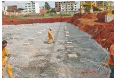
Figura 11 - Lançamento da camada de brita entre as estacas, já com os capitéis
