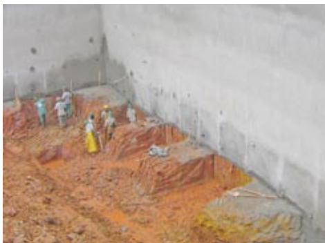
Figura 5 - Escavação manual com bermas entre as partes escavadas
