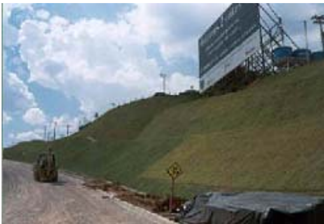
Foto 15 Vista do talude contido em Solo Grampeado, paramento com grama, Cond. Vila Amalfi
