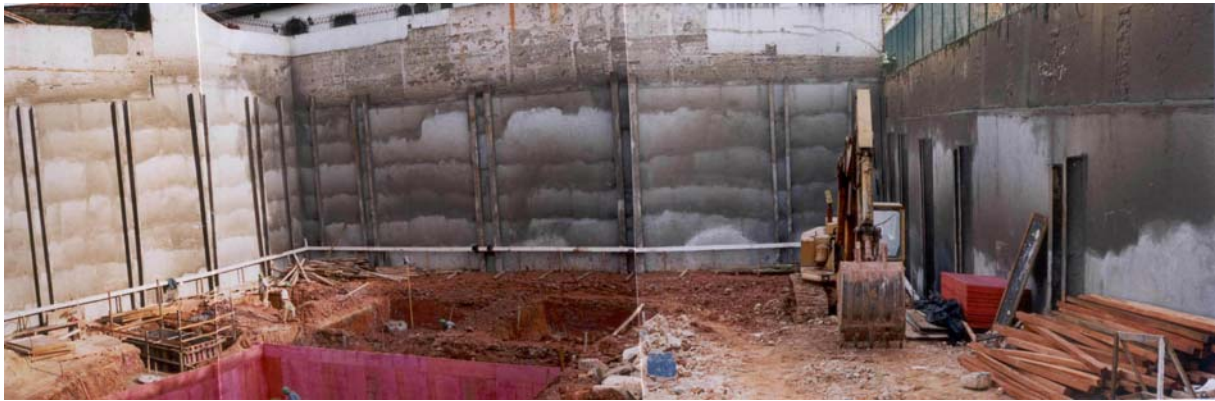
Foto 19 - Vista geral da obra durante a execução, R. das Goiabeiras
