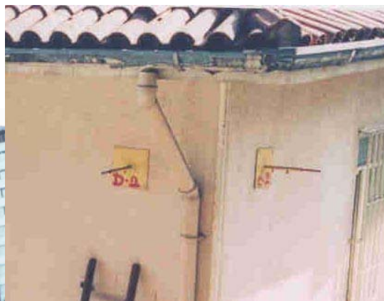
Foto 9A – Detalhe D2 e C2
