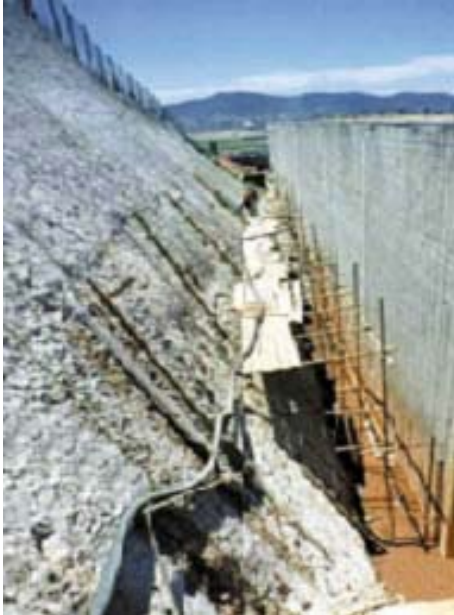
Foto 12 - Recuperação dos talude adjacentes, R. Indubel
