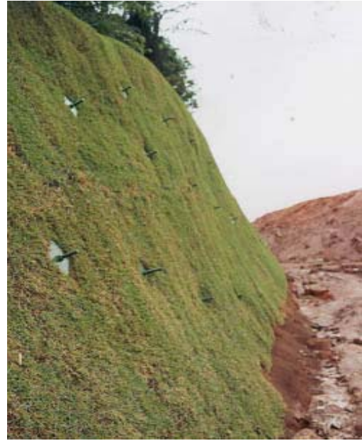
Foto 3 - Paramento em grama, e talude com chumbadores, Cond. Vila Amalfi
