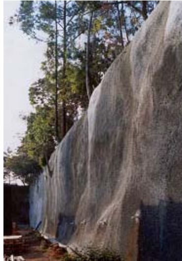
Foto 21 - Vista geral das paredes estabilizadas com paramento irregular, Rod. Anchieta
