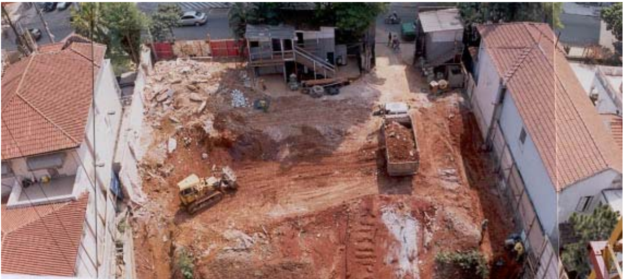
Foto 8 - Vista Geral da obra durante a fase final, com vizinhos, na divisa, Hosp. Benef. Portuguesa
