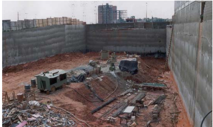
Foto 17 - Vista geral da obra durante a execução, Sto André
