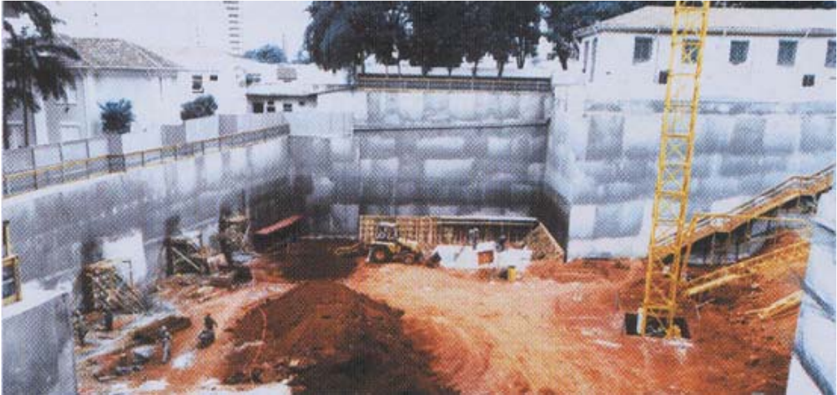
Foto 7 - Vista Geral da obra durante a primeira fase, Hosp. Benef. Portuguesa
