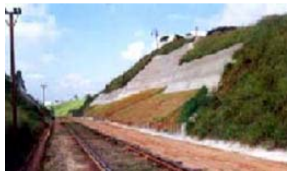
Foto 14 Vista do talude contido em Solo Grampeado, Suzano
