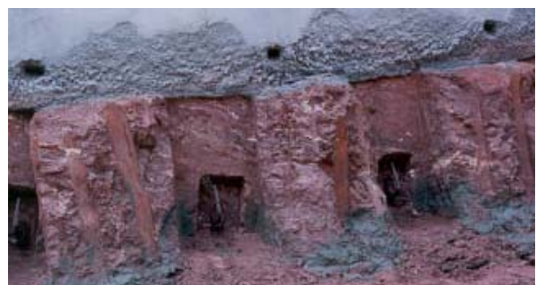
Foto 6 - Detalhe das damas provisórias entre chumbadores
