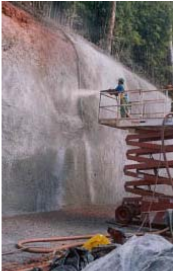
Foto 20 - Aplicação do concreto projetado, Rod. Anchieta
