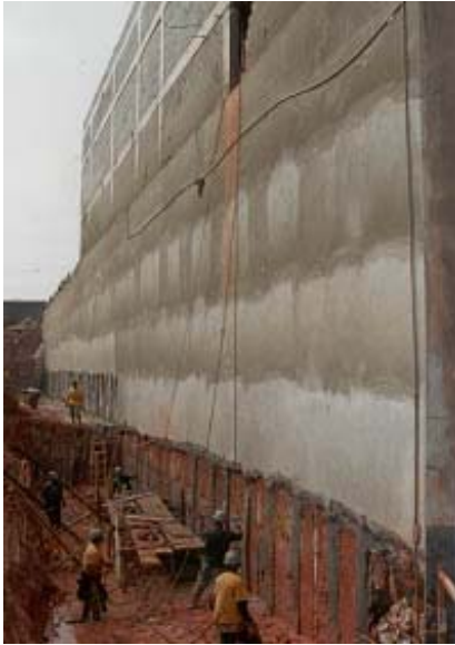
Foto 4 - Pilares provisórios de concreto projetado, Sto. André
