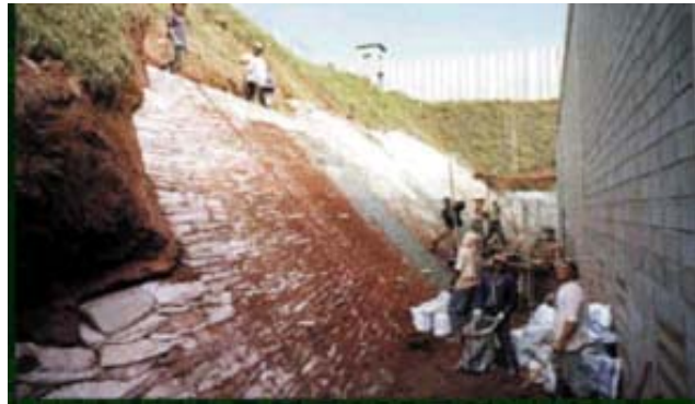
Foto 11 - Talude recomposto com solo-cimento, R. Indubel
