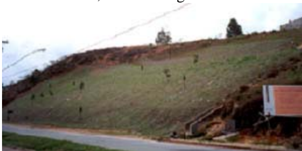
Foto 16 Vista do talude contido em Solo Grampeado, paramento com grama, Poços de Caldas
