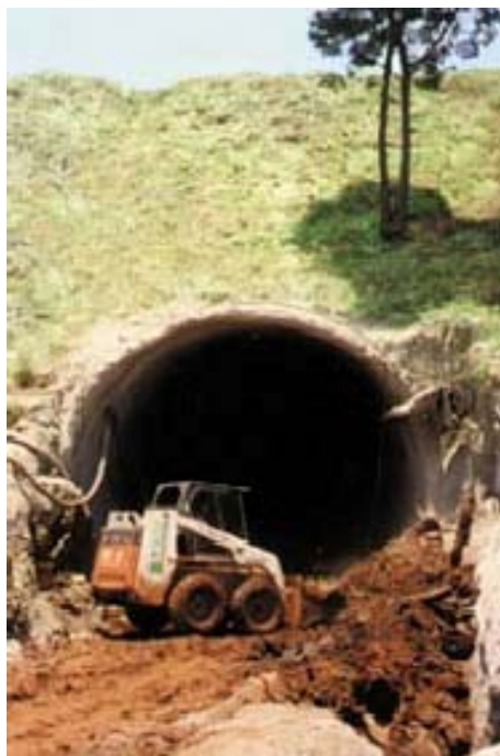
Foto12 Detalhe do emboque do túnel
