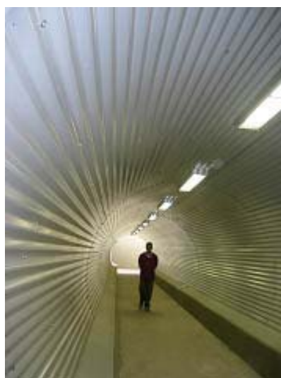
Foto 27 Vista interna do túnel acabado
