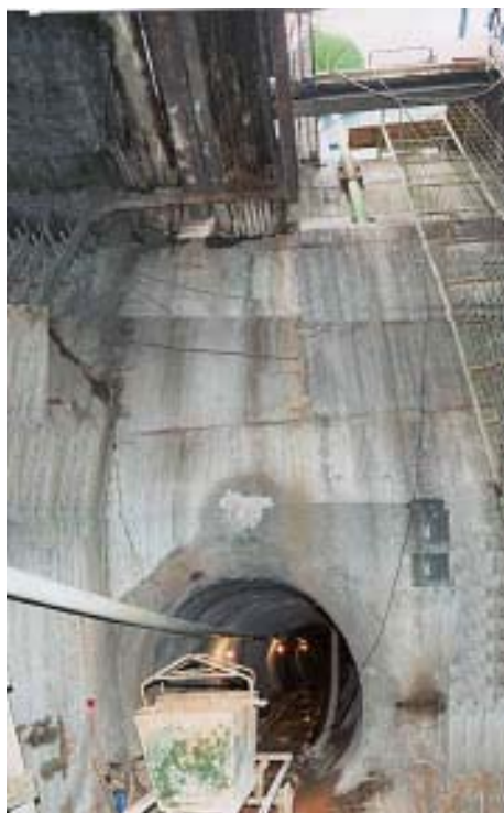
Foto 10 Detalhe do emboque do túnel junto ao poço de ventilação
