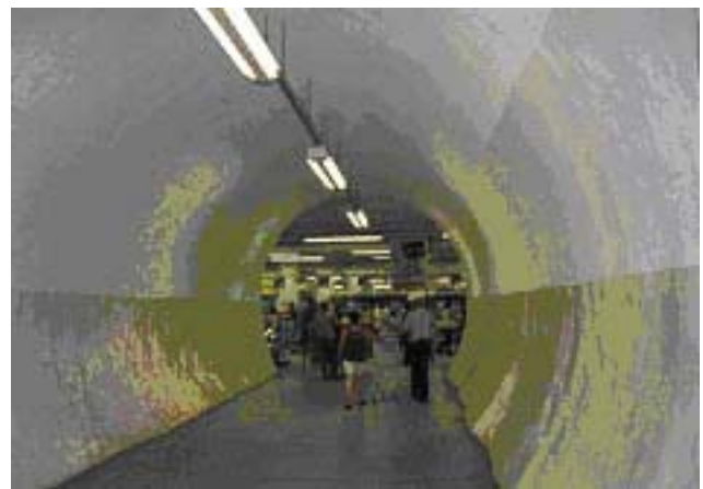
Foto 9 Túnel de pedestres pronto
