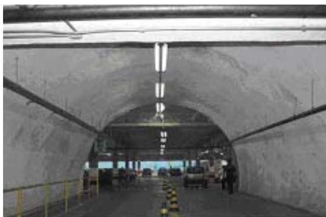
Foto 7 Túnel de veículos pronto
