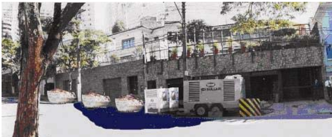
Foto 16 Vista frontal do imóvel com compressor, gerador e caçambas estacionadas na rua
