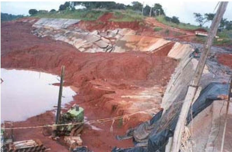
Foto 13 e Foto 14 – Aspectos das rupturas dos taludes por exemplo do solo junto ao emboque norte
