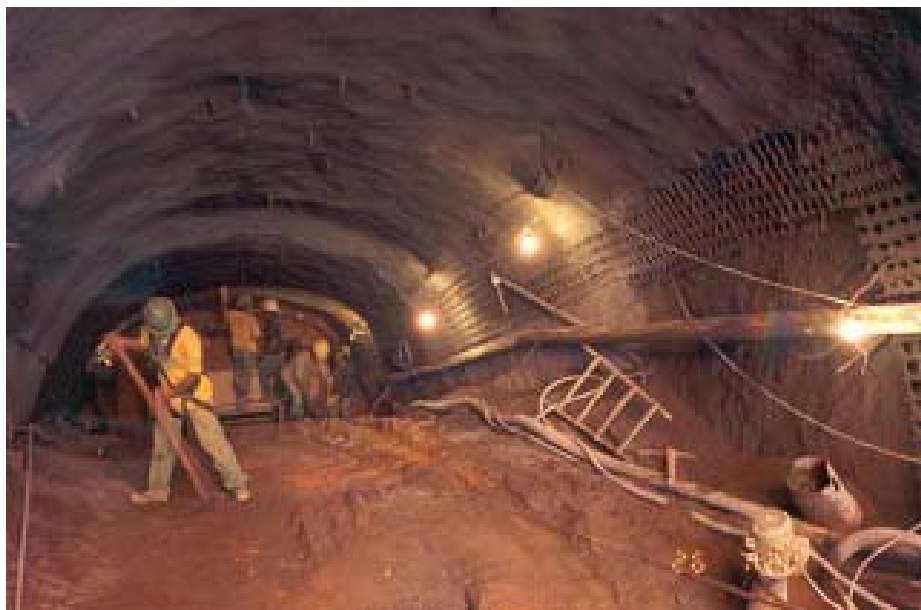
Foto 24 - Detalhe do túnel da correia transportadora com 29° de inclinação
