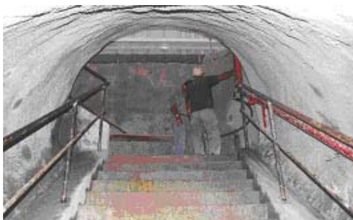
Foto 19 e foto 20 Túnel de acesso de pedestres ao poço com 37° de inclinação
