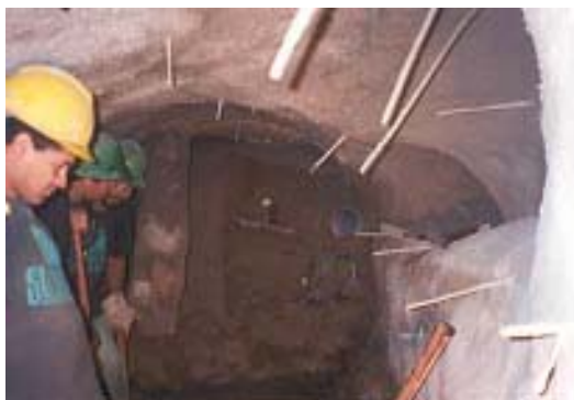
Foto 21 Ilustração das interferências encontradas de estacas e tubulões
