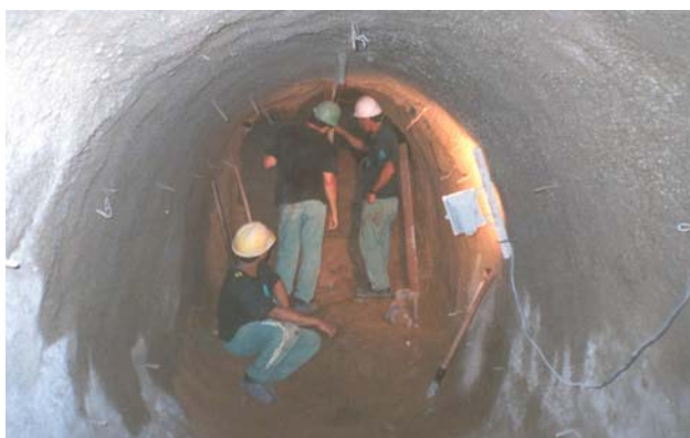
Foto 22 Marcação da geometria de escavação
