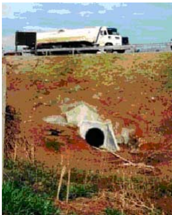
Foto 25 Vista do túnel pronto sob a rodovia
