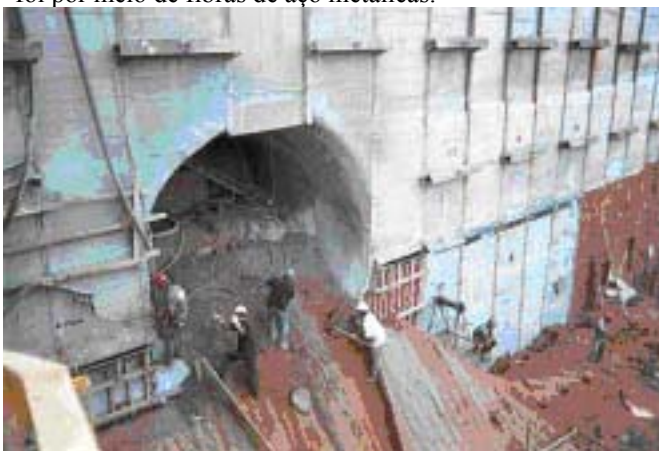
Foto 8 Detalhe da parcialização da seção de escavação e emboque do túnel de pedestres
