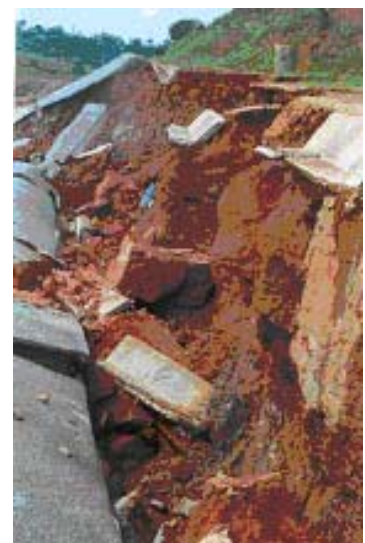
Foto 13 e Foto 14 – Aspectos das rupturas dos taludes por exemplo do solo junto ao emboque norte
