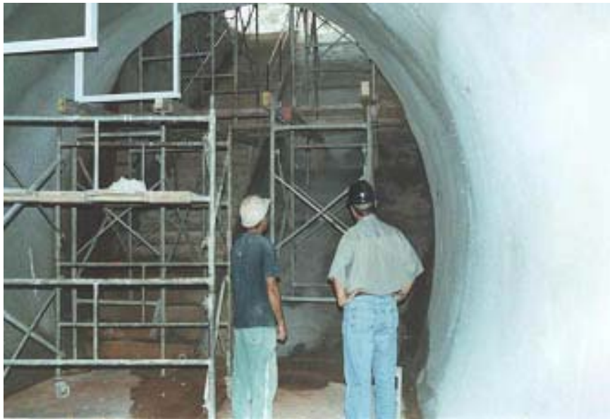
Foto 19 - Encontro da Galeria de Transporte de Rebarbas ao Poço de Acesso de 40 ° de Inclinação.
