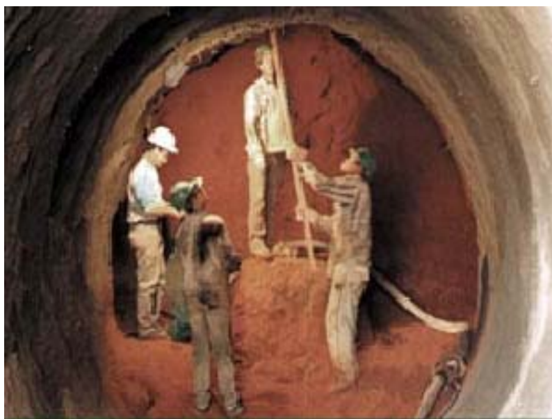
Foto 1 - Detalhe parcialização da seção de escavação
