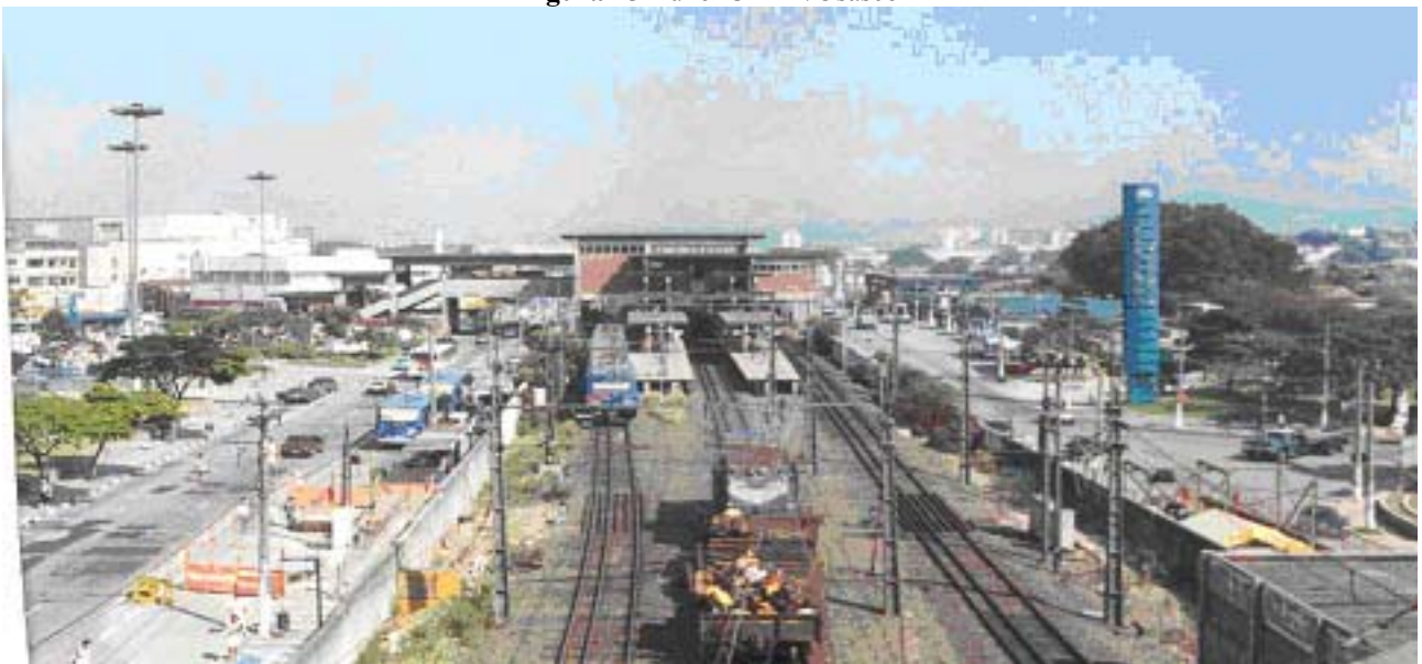
Foto 26 Detalhe da situação das cargas de superfícies Sobre o túnel
