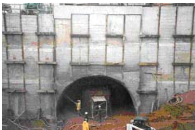
Foto 6 Detalhe de parcialização da seção de escavação e emboque de túnel de veículos
