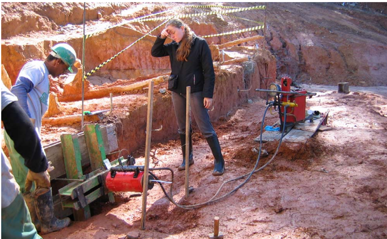
Fotos 25– Ensaio de arrancamento
