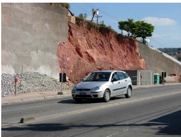
Foto 8 – Obra na Rod. Raposo Tavares – Cotia - SP
