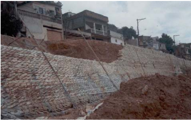
Foto 3 – Obra em Taboão da Serra - SP
