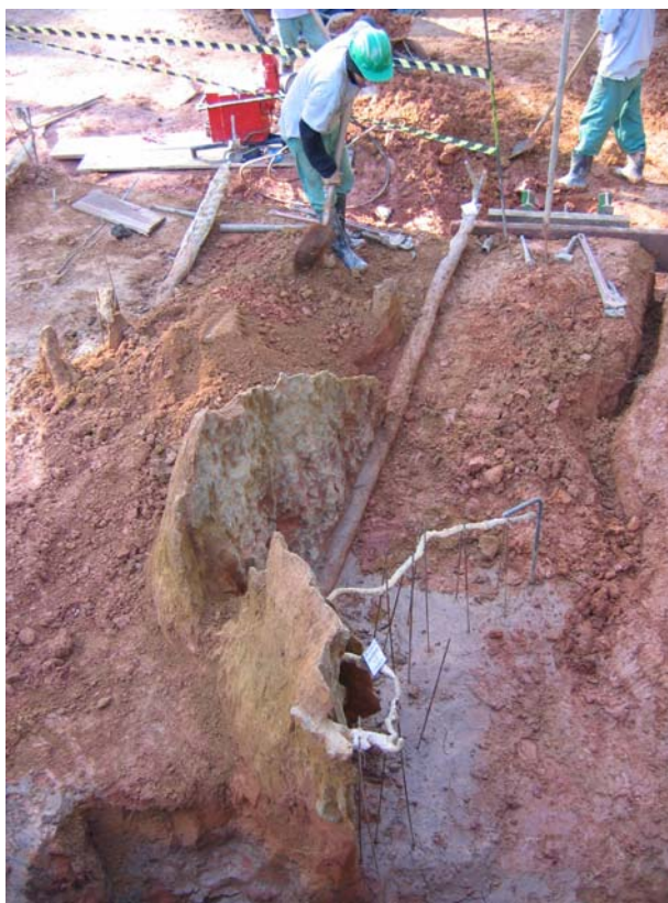
Fotos 23– Chumbador 02 parcialmente escavado
