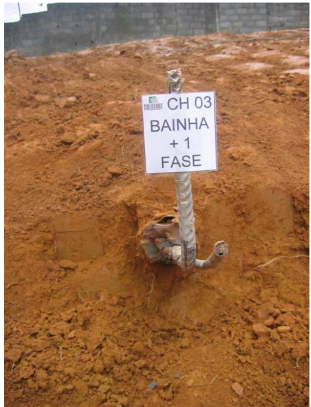
Fotos 15– Chumbador 03 injetado com bainha e 1 fase
