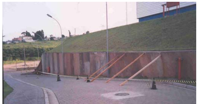
Foto 6 – Obra Finalizada – Stiefel - Guarulhos SP
