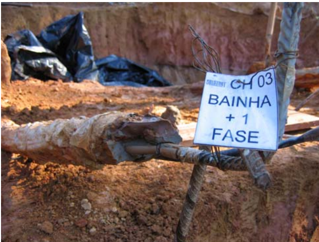
Fotos 19– Chumbador 03 injeção da 1ª fase complementa a bainha
