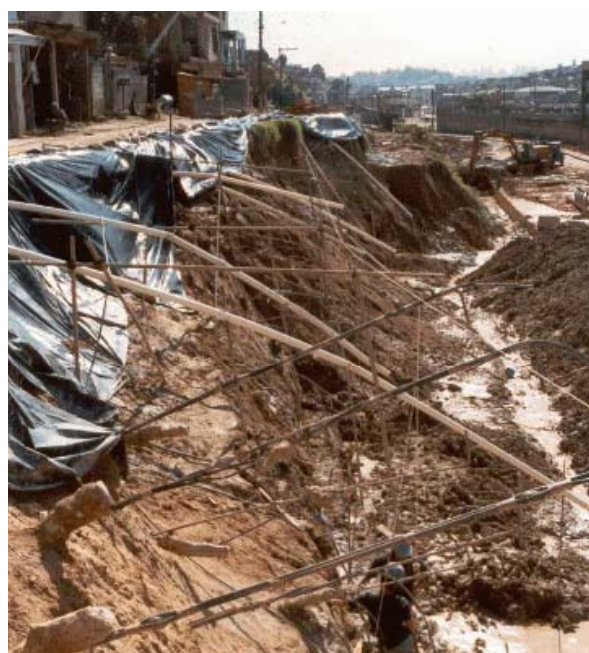
Foto 2 – Início das Obras - Taboão da Serra - SP
