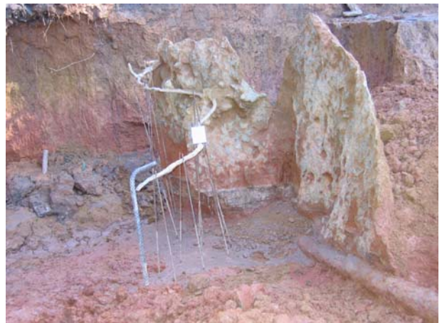
Fotos 22– Chumbadores 02 parcialmente escavado
