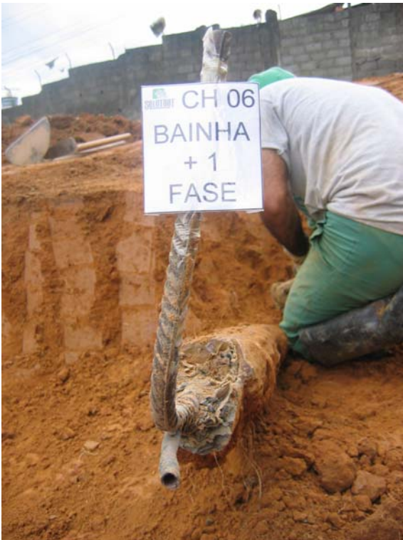
Foto 16– Chumbador 06 injetado com bainha e 1 fase
