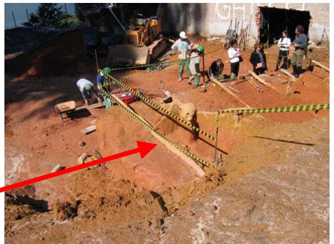
Fotos 18– Chumbador 06 parcialmente escavado
