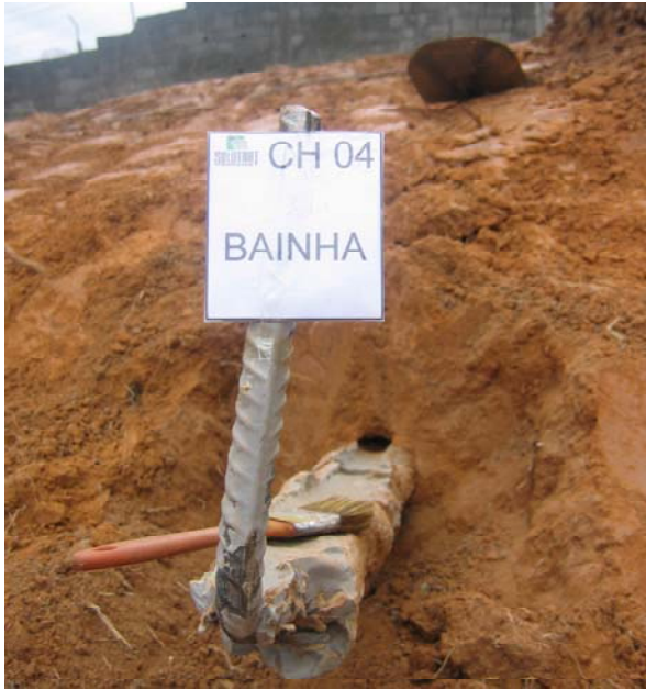
Foto 12 – Chumbador 04 injetado só com a bainha
