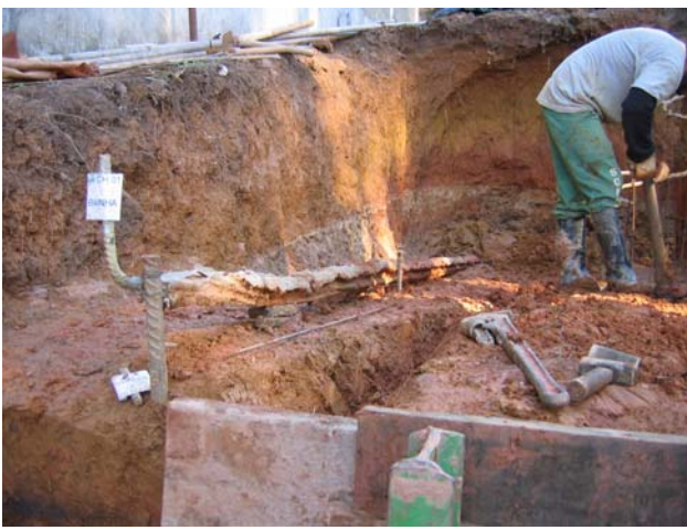
Foto 13– Chumbador 01 parcialmente escavado
