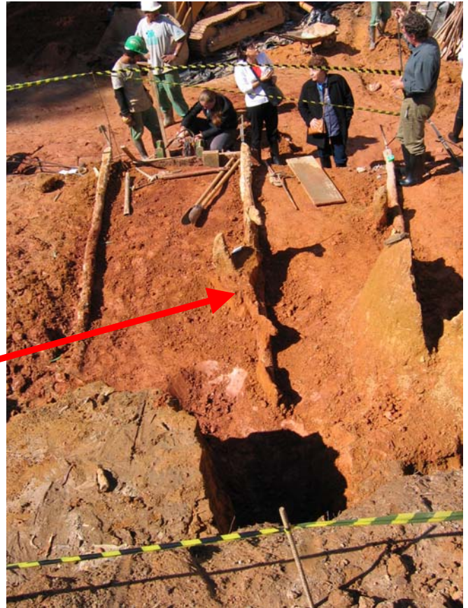
Fotos 17– Chumbador 03 parcialmente escavado
