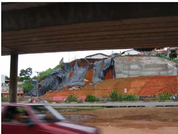
Foto 7 – Obra em Salvador - BA
