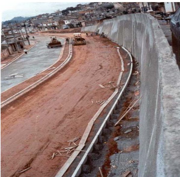
Foto 4 – Obra Finalizada – Taboão da Serra - SP
