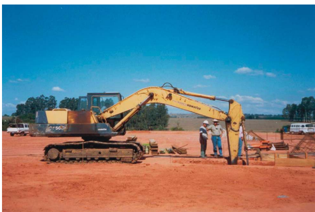
FIG.15-Detalhe da escavação inicial mecanizada
