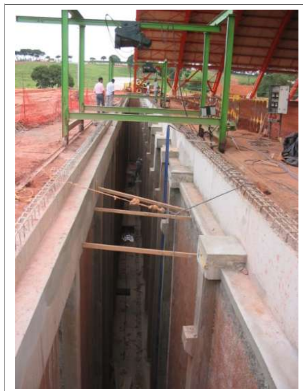
b) Topo da vala
