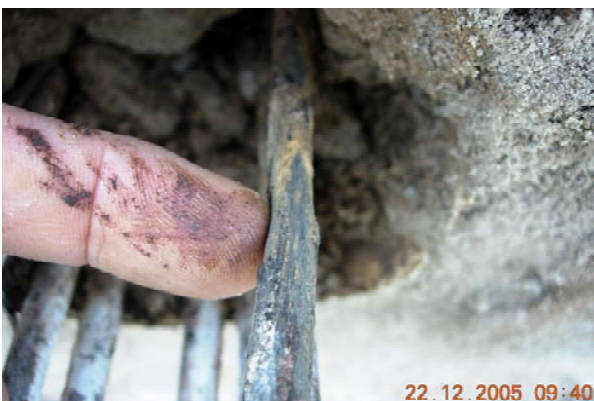
Foto 15 – Detalhe do fio com local que sofreu escoamento
