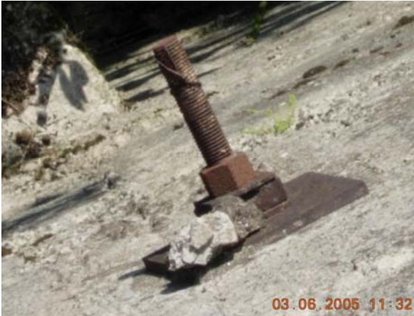
Foto 18 - Cabeça de ancoragem com porca, para fios barra única
