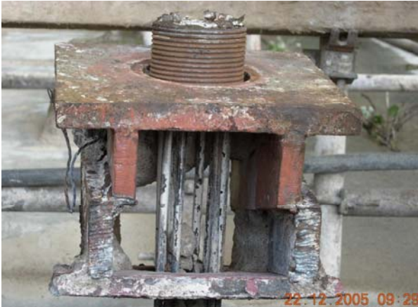
Foto 13 – Detalhe da placa e parafusão
