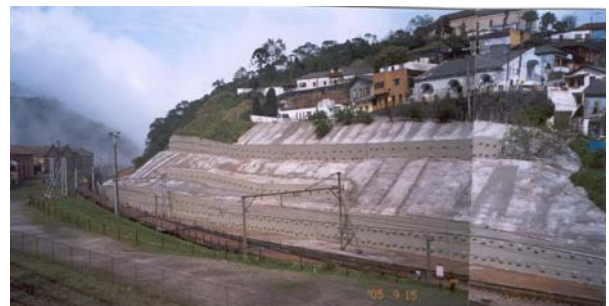
Foto 9 – Execução do reforço da cortina pela Solotrat Engenharia Geotécnica Ltda
