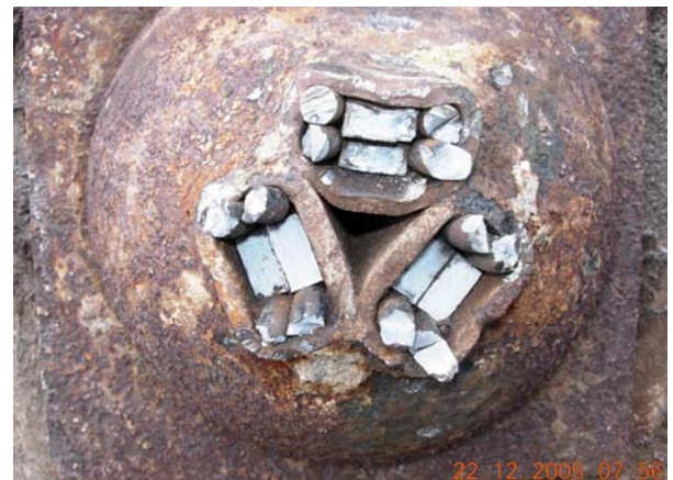
Foto 17 - Cabeça de ancoragem capacete de aço e cunhas, para fios de 7 ou 8mm
