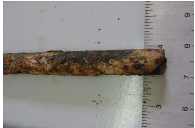
Foto 7 – Fio de aço de 8mm totalmente corroído.
