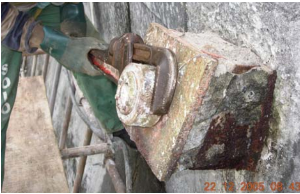
Foto 12 – detalhe do tensionamento, porca e parafusão.
