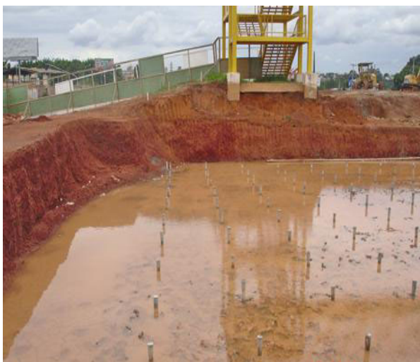
Figura 10. Parte das estacas instaladas no local do futuro acesso ao viaduto.
