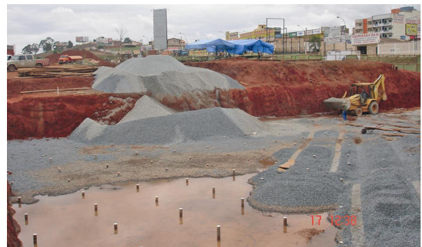
Figura 11. Lançamento da brita.
