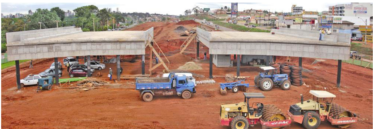
Figura 5. Visão geral do encontro entre viadutos, antes de ser iniciado o estaqueamento com Alluvial Anker.
