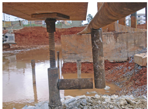
Figura 22. Instrumentação vertical e horizontal da estaca-teste.
