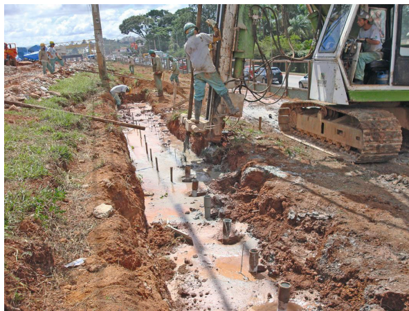
Figura 6. Instalação das estacas alluvial anker para proteção da adutora.
