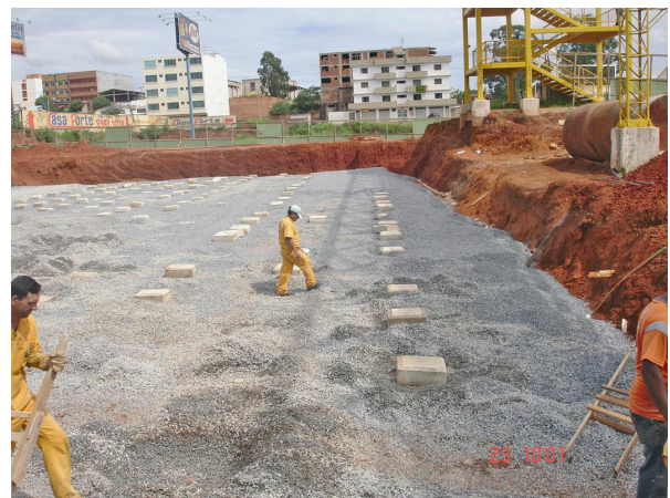
Figura 12. Estacas com capitéis e camada de brita.
