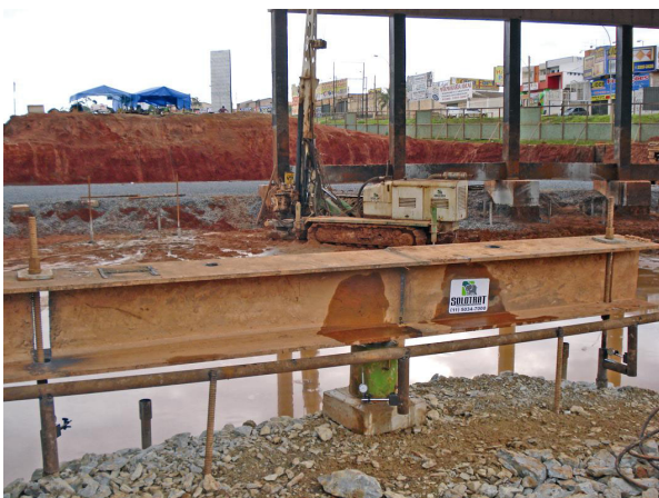
Figura 21. Vista geral da montagem da prova de carga.
