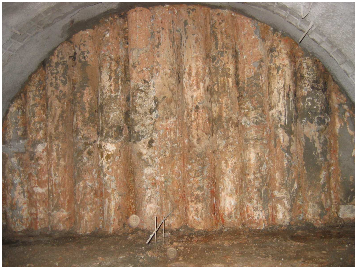
Fig 10 – Cortina de estacas justapostas no desemboque do Canal Tomada D'água.
