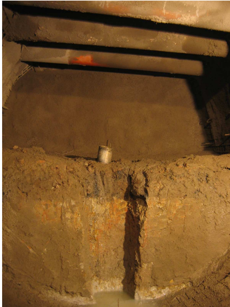
Fig 9 – Detalhe dos tubos colocados no leito do Canal Perimetral.
