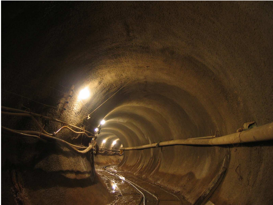
Fig 4 – Túnel finalizado – detalhe da retificação do traçado.
