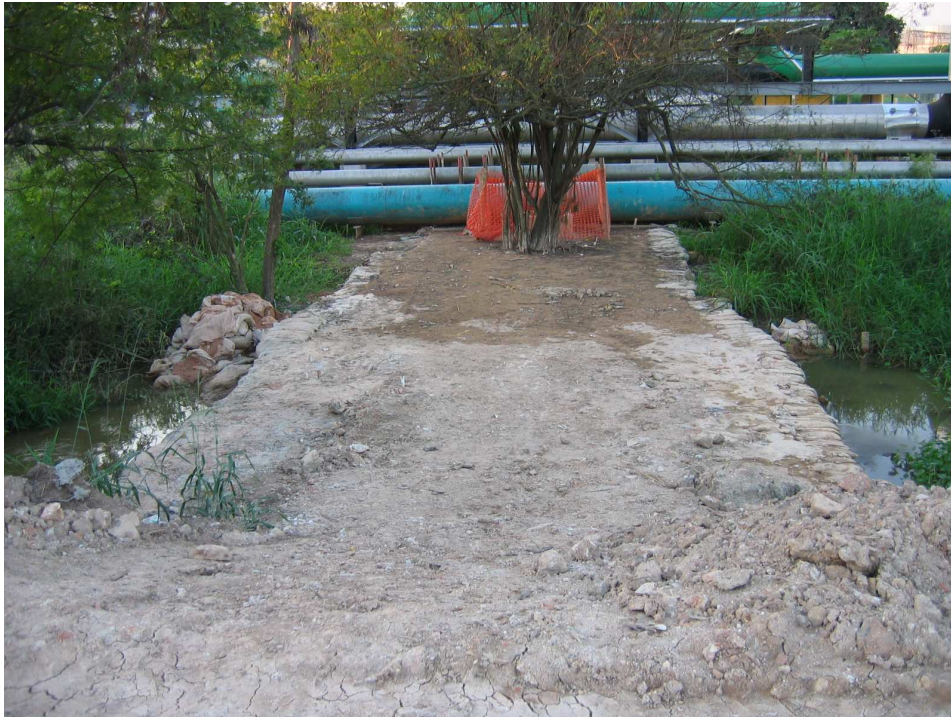
Fig 8 – Preenchimento do Canal Perimetral para passagem do túnel.
