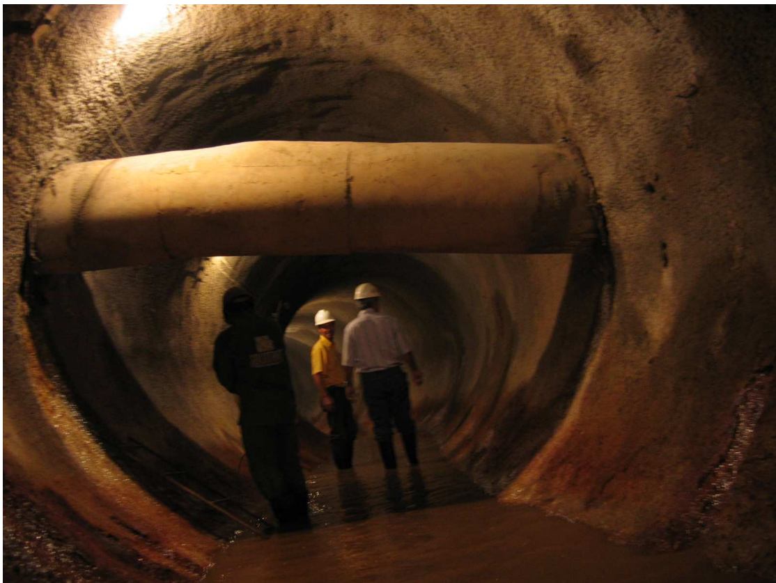
Fig 7 – Oleoduto ORBEL 1, no interior do túnel
