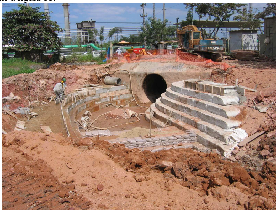
Fig 11 – Integração do túnel com o Canal Honorato.
