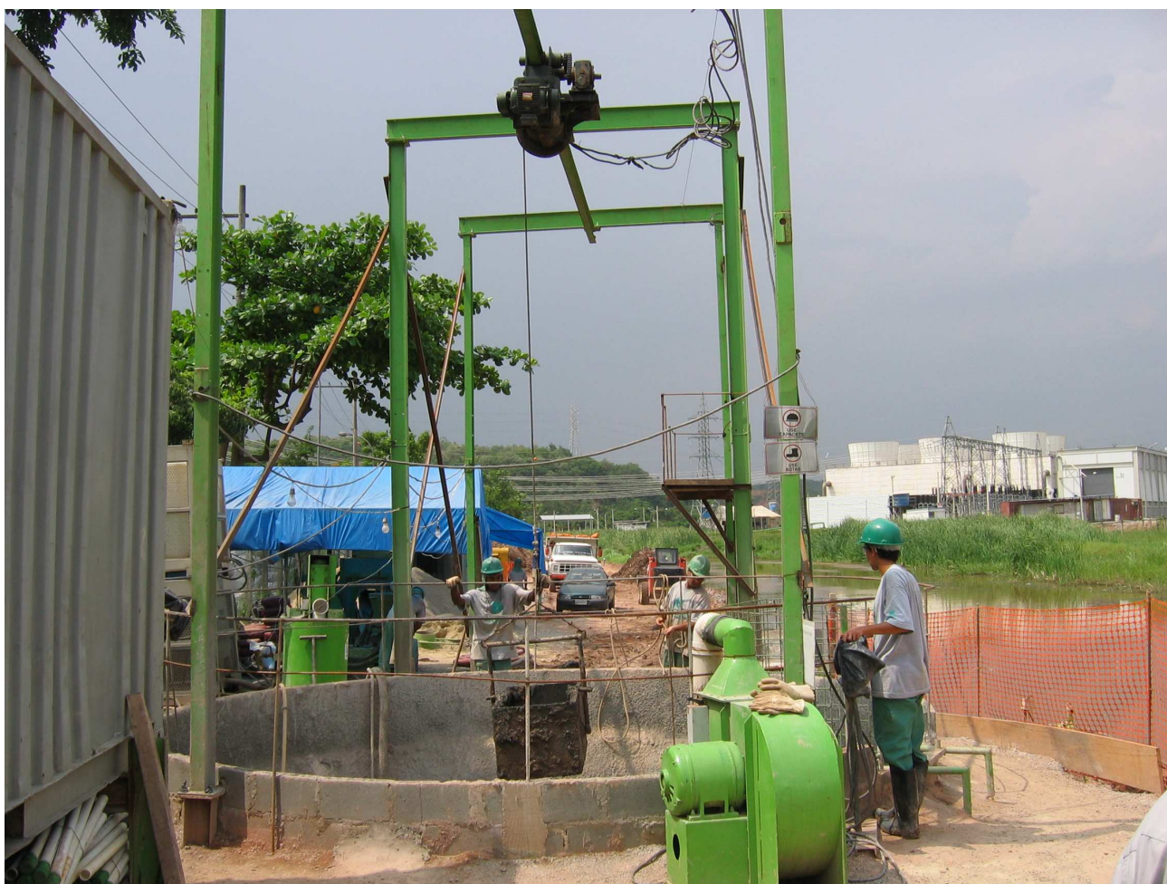
Fig 3 – Instalações e poço de acesso.
