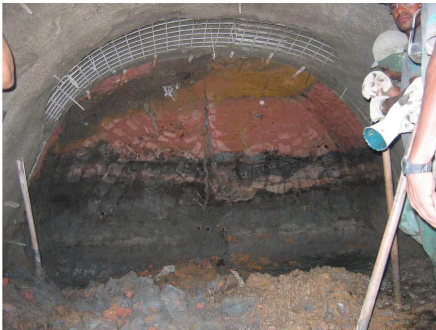
Fig 1 – Frente de escavação do túnel.
