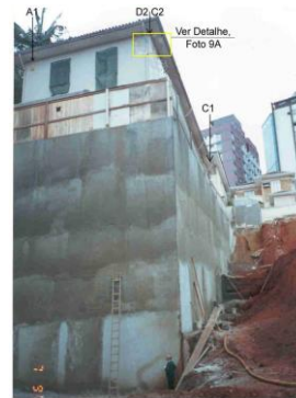
Figura 47 – Vistas da obra
