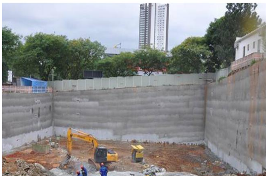
Figura 61 – Projeto e foto da obra
