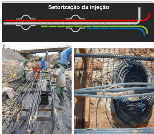
Figura 14 – Montagem do chumbador em bancada
