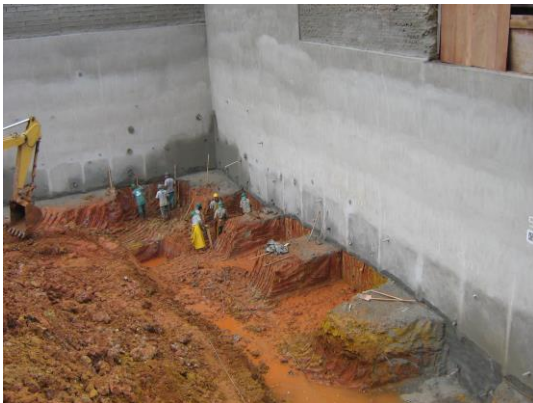
Figura 40 – Execução com Bermas
