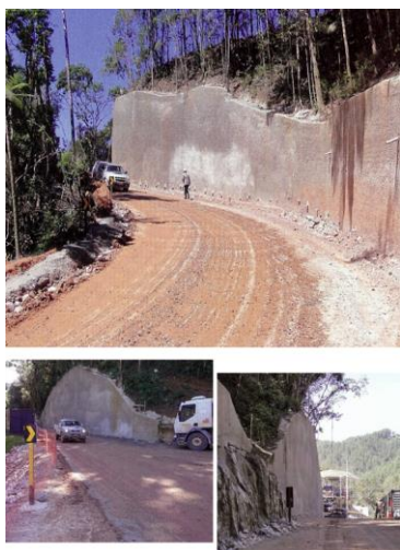
Figura 59– Imagens da obra
