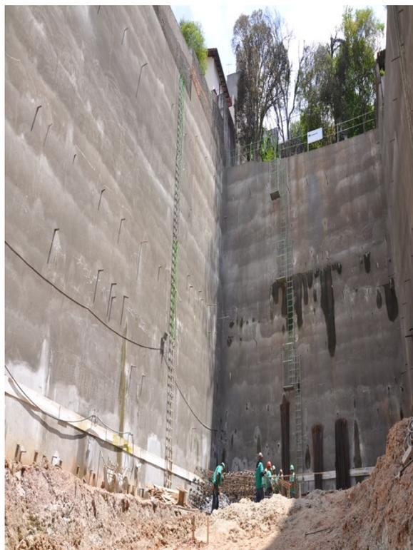
Figura 9. Vista de uma das contenções em solo grampeado utilizando a técnica de reinjeção pressurizada – altura de contenção de 17,7 m
