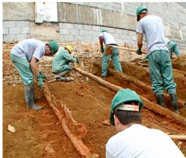
Figura 4. Exumação de grampos que foram injetados pela técnica de reinjeção setorizada, em que a maior rugosidade da superfície pode ser vista. (Zirlis et al., 2015)
