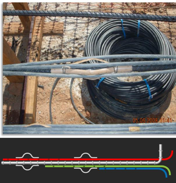
Figura 2. Detalhe dos tubos perdidos deixados para a reinjeção, juntos à armação do grampo e aos centralizadores
