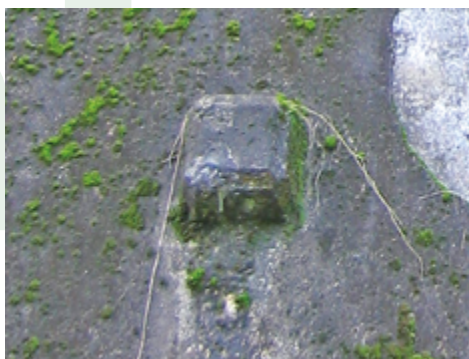
Figura 12 - Fluxo de água na cabeça do tirante.
