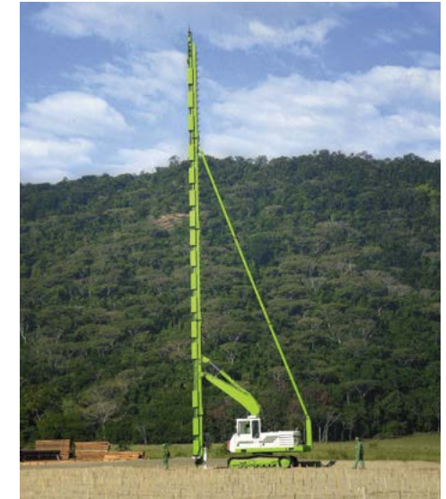
Figura 4 - Equipamento em serviço de cravação de geodrenos.
