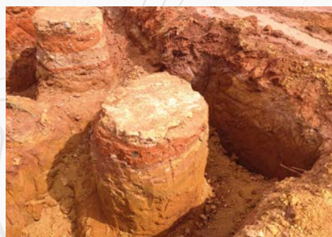
Figura 3 - Colunas escavadas - Aferição de diâmetro.
