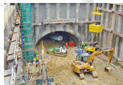
Figura 8 - Túnel metroviário, com seção de 66,0m².
