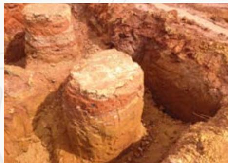
Figura 3 - Colunas escavadas - Aferição de diâmetro.
