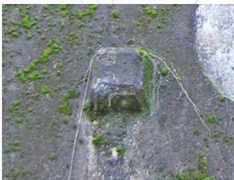
Figura 12 - Fluxo de água na cabeça do tirante.
