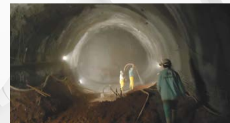
Figura 13 - Túnel de interligação entre edifícios.
