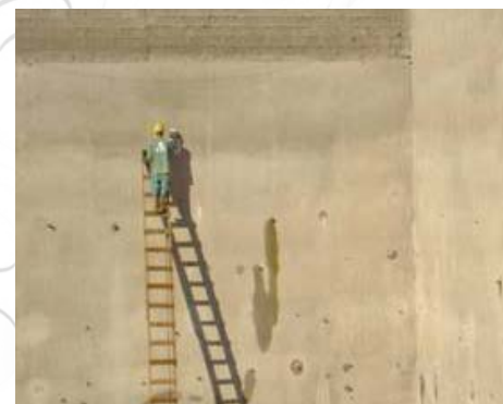
Figura 25 - Leitura de Deformação Horizontal.
