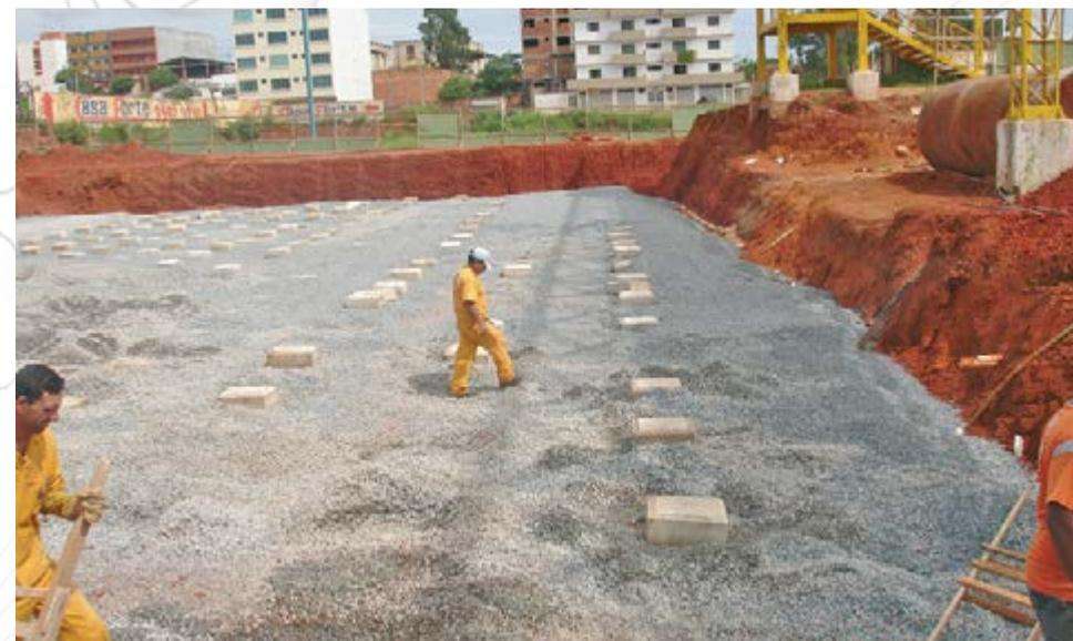
Figura 11- Lançamento da camada de brita entre as estacas, já com os capitéis.
