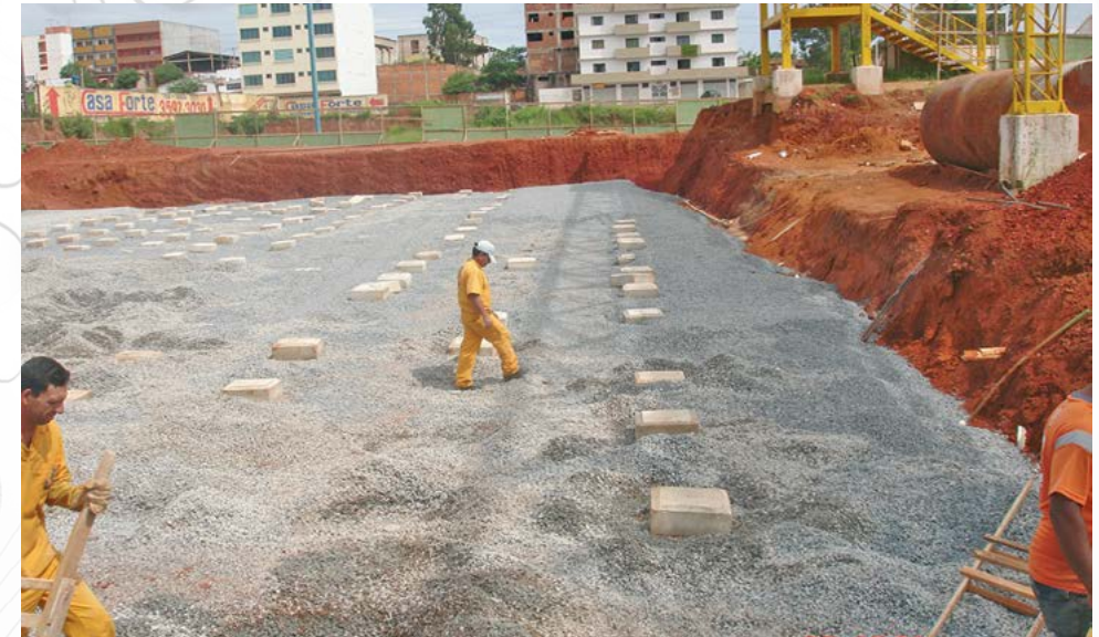
Figura 11- Lançamento da camada de brita entre as estacas, já com os capitéis.
