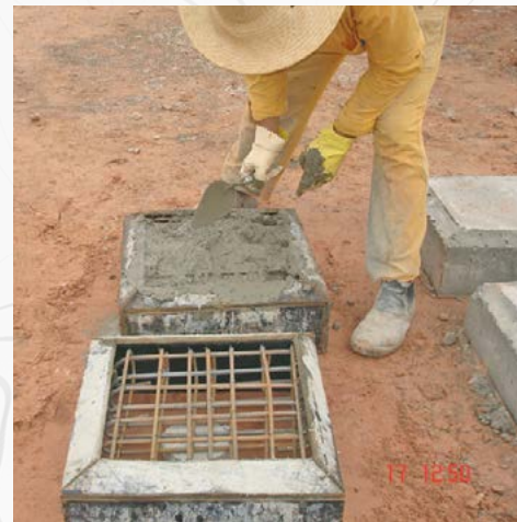
Figura 10- Execução de capitel para SS Anchor, no local da obra.
