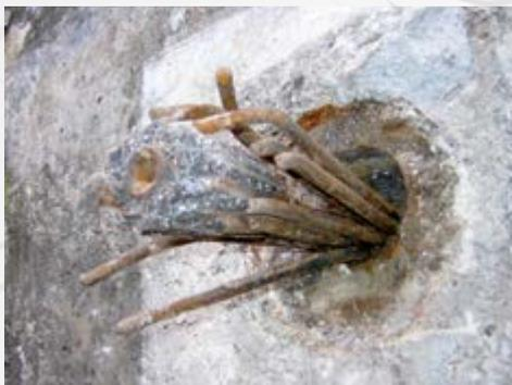
Figura 9 - Patologia - cabeças metálicas em processo de corrosão.
