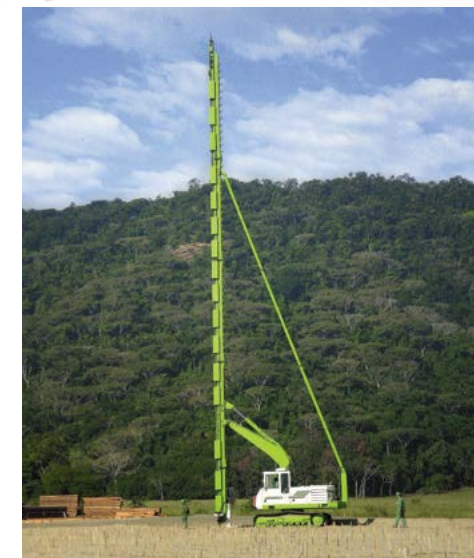
Figura 4 - Equipamento em serviço de cravação de geodrenos.
