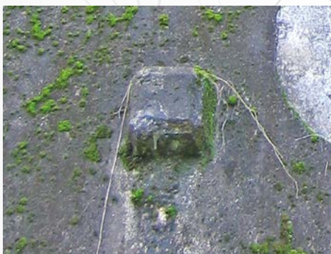
Figura 12 - Fluxo de água na cabeça do tirante.
